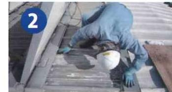
2 あらゆる防水工事をしても漏水が止まらない中、全体に漏水ストッパーを塗り込みます。（MP-1000も併用し、二重の止水処理を実施）
