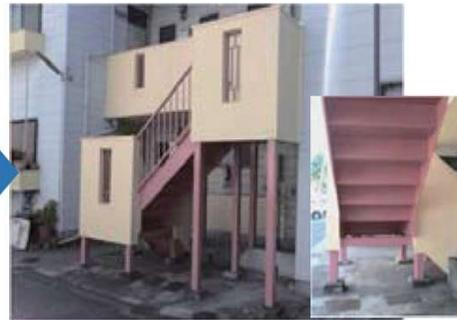
腐食が進行している場合は、バサルトシートで補強することができ、鉄板をはめでの溶接処理などの必要なく再生と延命をすることができます。
