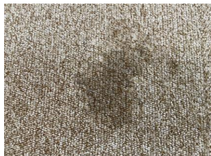
施工前は水分が浸透
