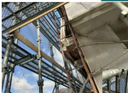
鉄骨階段は酸化防止持続処理施工
